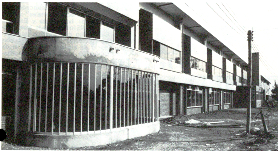
175 mil volúmenes albergará la nueva Biblioteca Central, ubicada en el Campus San Joaquín.
